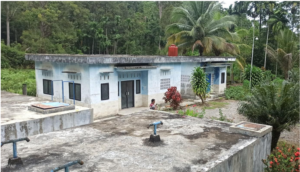
Gambar 1.17. Bangunan Penyimpan Air Bersih dan Bangunan Karyawan Penanggung Jawab IKK dan Ruang Genset.
