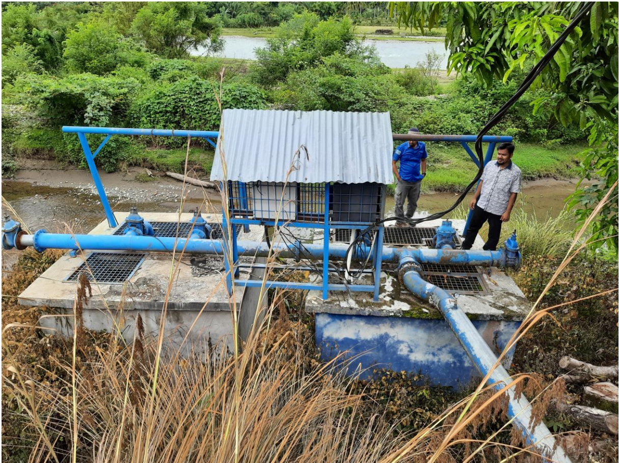
Gambar 1.14. Bangunan Pengambil Air Baku IKK Lembah Sabil.
