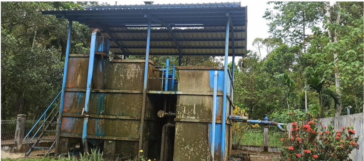
Gambar 1.16. Bangunan Produksi IKK Tangan-Tangan.
