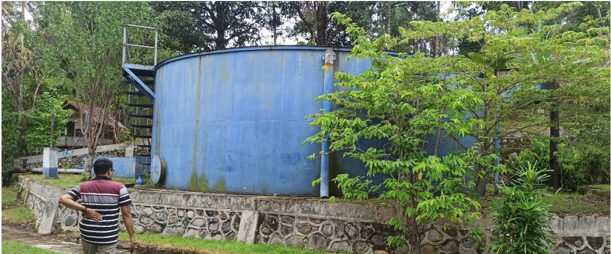
Gambar 1.13. Bangunan Produksi IKK Lembah Sabil.
