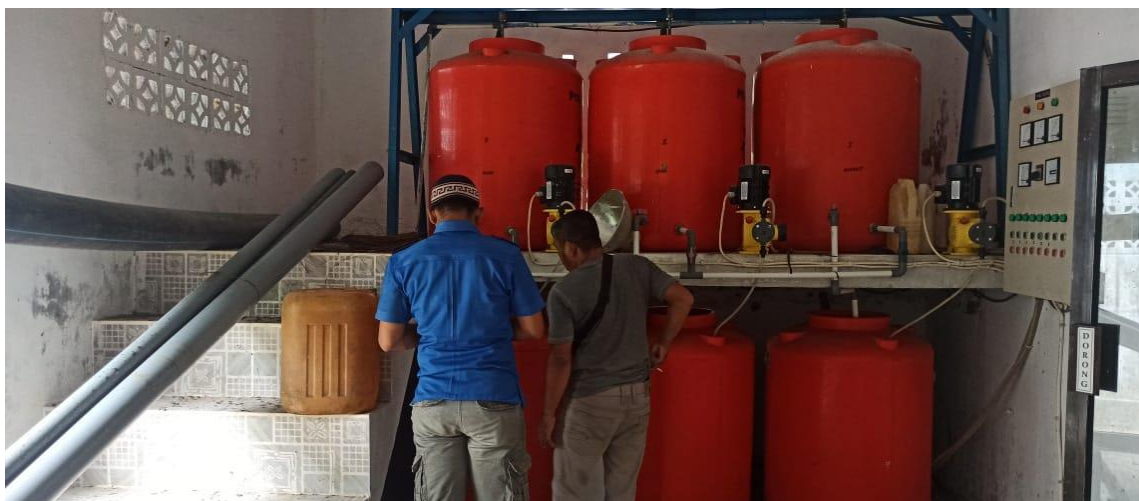
Gambar L10. Survei ke Ruang Injeksi Koagulan di Lokasi IPA Tangan-Tangan.
