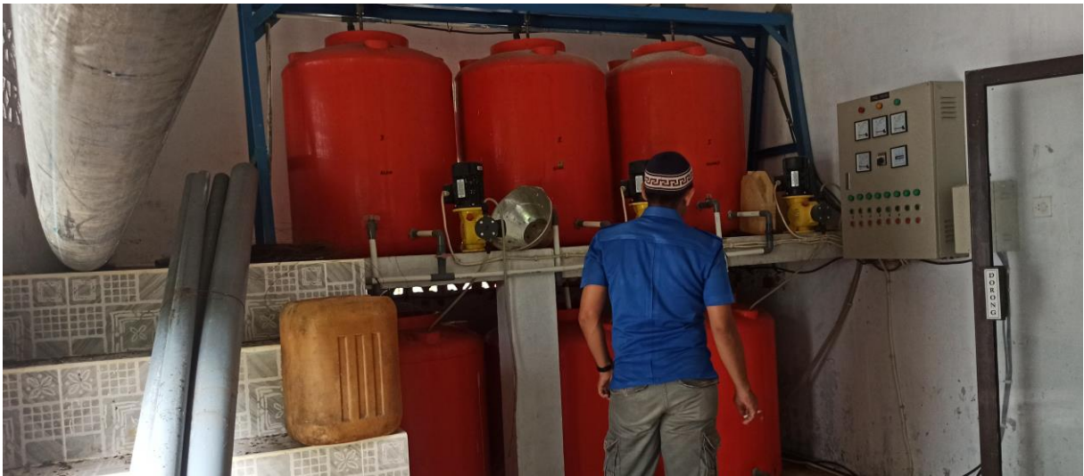
Gambar 1.19. Ruang Injeksi Koagulan IKK Tangan-Tangan.
