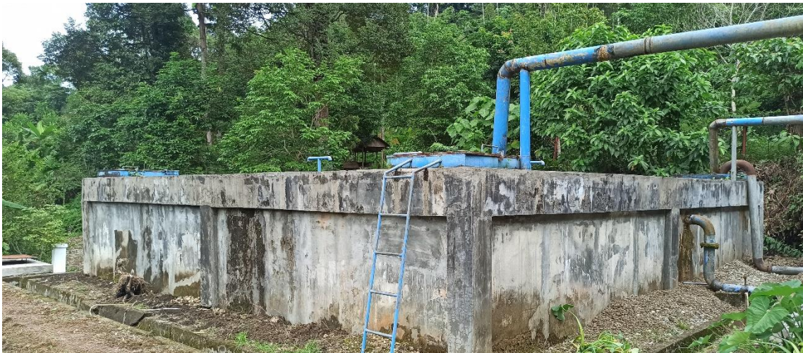
Gambar L12. Survei ke Lokasi Penampungan Awal Air Baku di Lokasi IPA Jeumpa.
