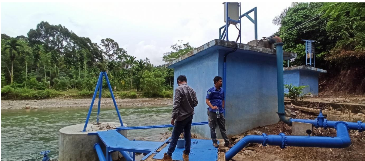
Gambar 1.21. Bangunan Pengambil Air Baku IKK Blang Pidie.
