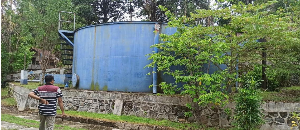
Gambar L6. Survei ke Lokasi IPA Lembah Sabil.
